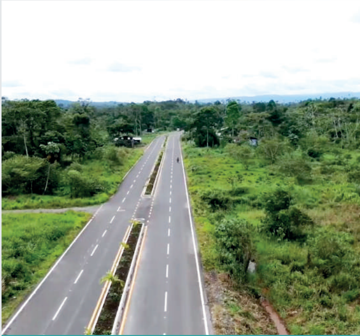
Construcción de bordillos
