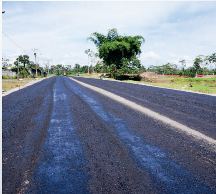
Colocacion carpeta asfaltica calles urbanas de Huamboya
