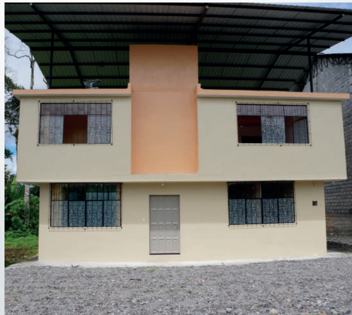
Centro de aislamiento
