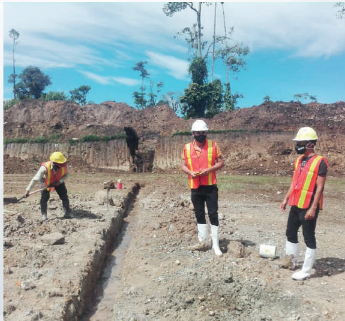
Construcción de celda para desechos inorgánicos en el relleno sanitario
