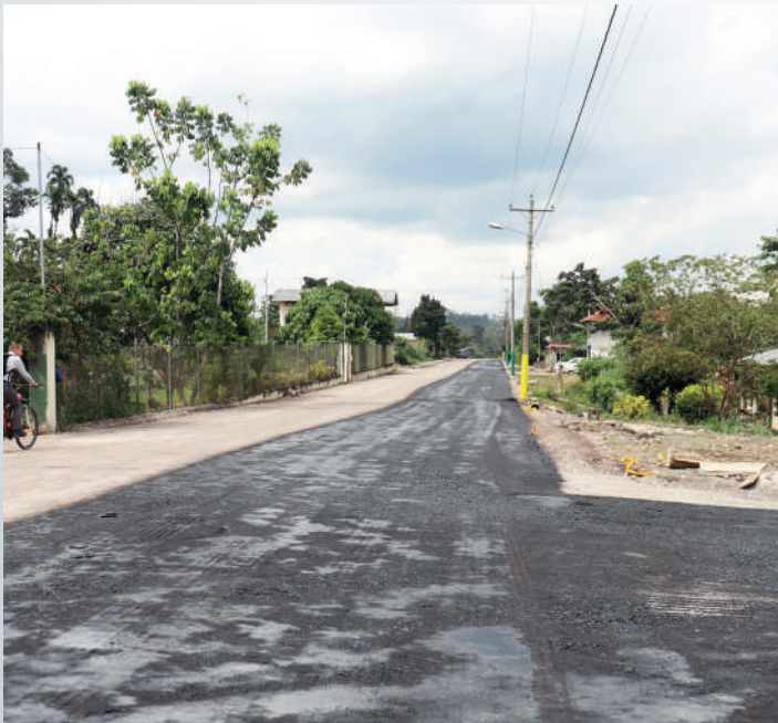
Mantenimiento y mejoramiento vial a nivel sub base
