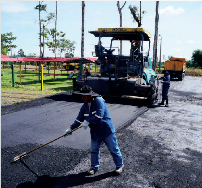
Colocacion carpeta asfaltica calles urbanas de Huamboya
