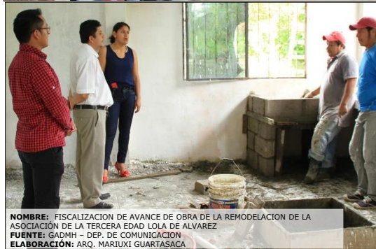
NOMBRE: REMODELACION DEL EDIFICIO DE LA ASOCIACIÓN DE LA TERCERA EDAD LOLA DE ALVAREZ FUENTE: GADMH - DEP. DE COMUNICACION ELABORACIÓN: ARQ. MARIUXI GUARTASACA
